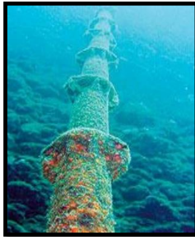
Gambar 9. 6 saluran kabel bawah laut
