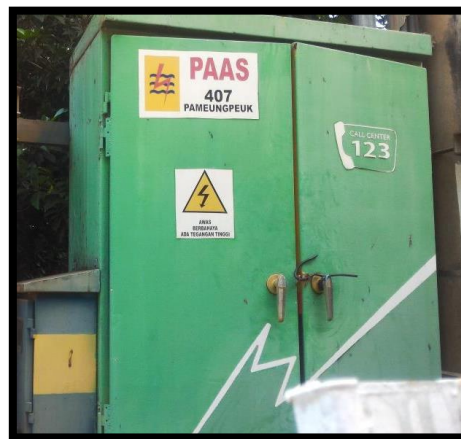
Gambar 10. 13 gardu tipe metal clad
